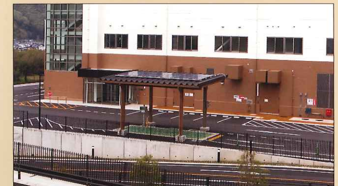
⑫太陽光パネル 屋上にソーラーパネルを設置、自然エネルギーを施設内で有効活用しています。
