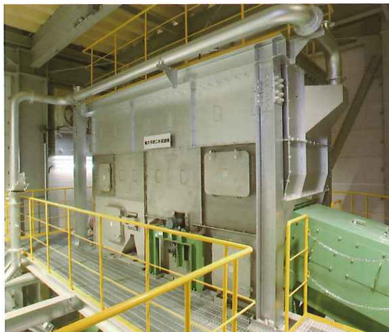
③磁選機 強力な磁力で鉄類を回収します。
