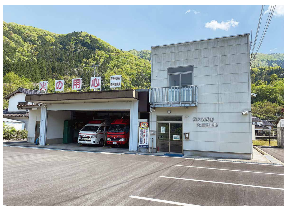
養父消防署大屋出張所のアスファルト舗装等の工事
