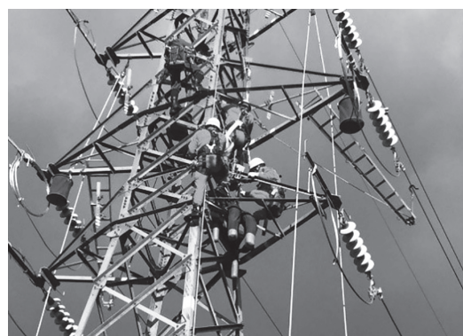
送電線事故対応救助訓練 (11月15日)
