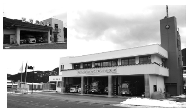
耐震改修工事完了
